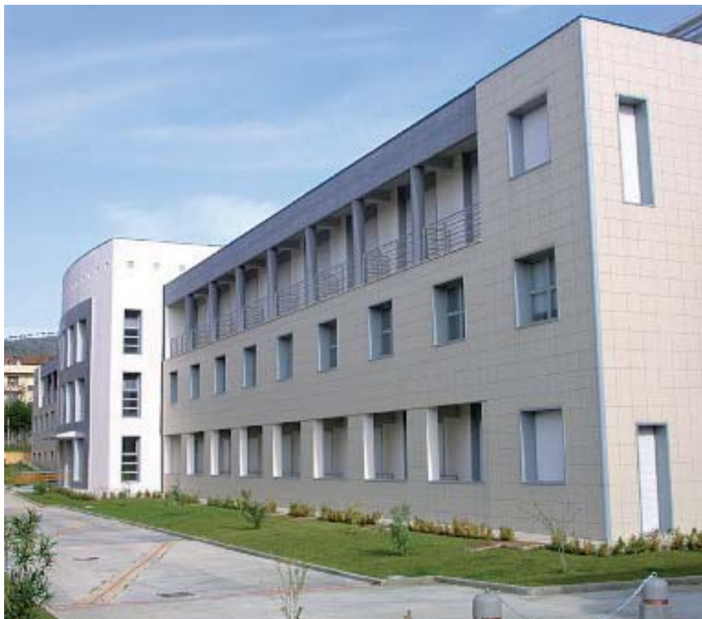
Gli inquinanti indoor sono numerosi, le loro concentrazioni variabili nel tempo in base a sorgenti interne, ventilazione e abitudini degli occupanti. (immagine Ospedale di Caserta)
